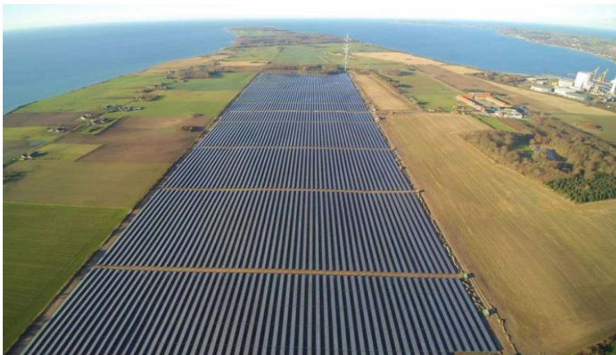
Norden største solcellepark, ved Kalundborg (foto: Wirsol/Ingeniøren)
