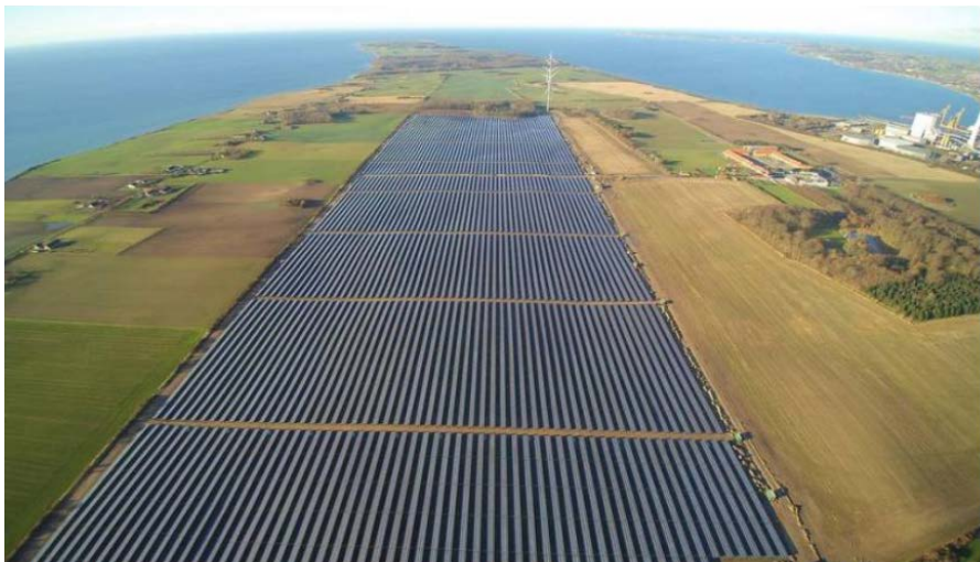
Norden største solcellepark, ved Kalundborg (foto: Wirsol/Ingeniøren)
